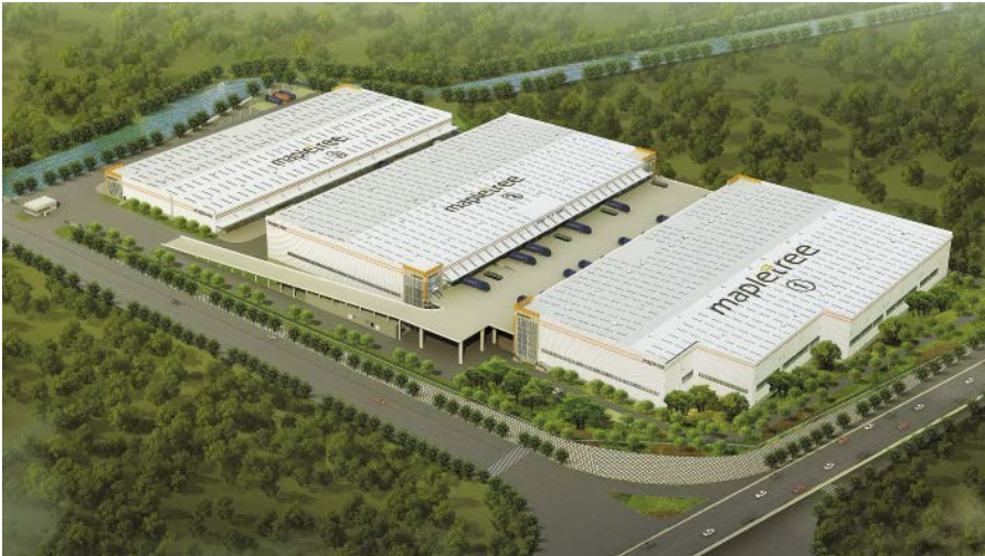
Mapletree Chongqing Liangjiang Logistics Park (メープルツリー重慶両江ロジスティクスパーク)には、ランプウェイを備えた2階建て倉庫2棟と、クロスドッキング設備のある平屋建ての倉庫1棟が完成予定です
