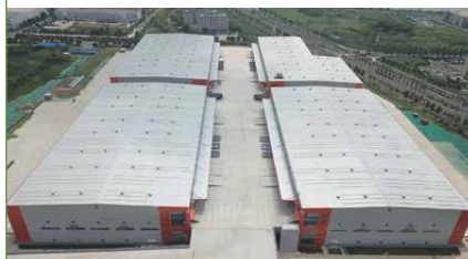
丰树(南京)综合服务产业园
