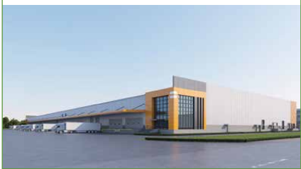
新加坡丰树沧州现代供应链产业园
