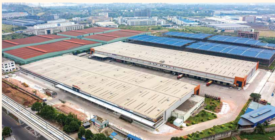
丰树重庆江津综合产业园靠近重庆外环高速和成渝高速公路，地理位置优越。
