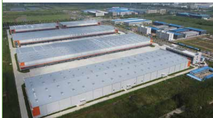
丰树团风综合产业园
